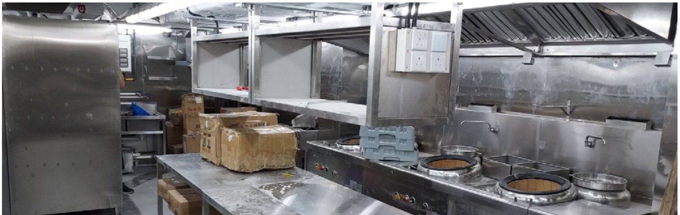
• 不銹鋼工作枱 / 不銹鋼吊架 / 不銹鋼星盤 / 上牆層板 / 廣東式環保炒爐 / 油煙罩
