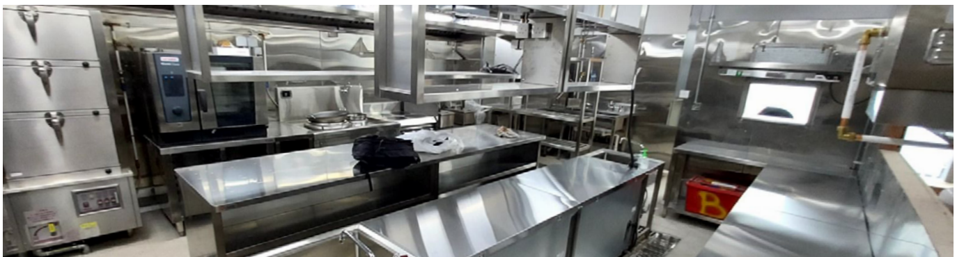
• 多用途蒸焗爐 / 電熱三門壓力蒸櫃 / 不銹鋼工作枱 / 不銹鋼吊架 / 不銹鋼星盤 / 廣東式環保炒爐
